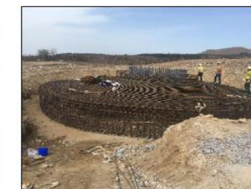
Montage de l'armature Source : Artifex 2018
