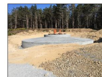
Fondation non remblayée Source : Artifex 2018
