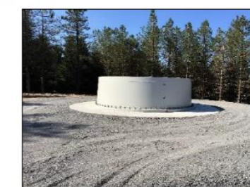
Fondation remblayée Source : Artifex 2018
