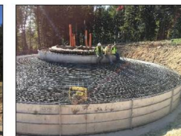
Montage de l'armature Source : Artifex 2018
