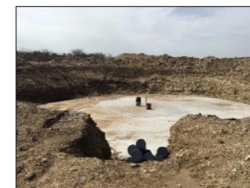
Excavation et béton de propreté Source : Artifex 2018
