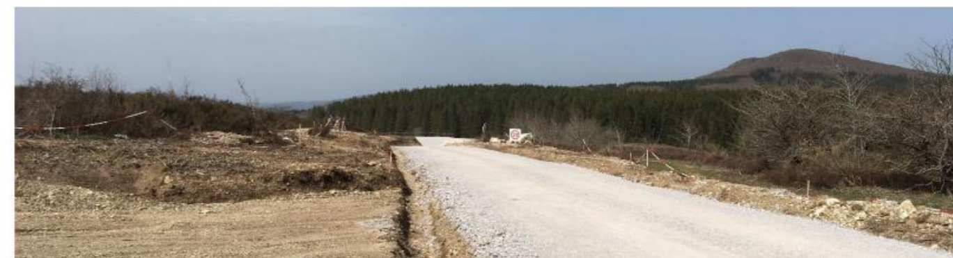
Construction d'une piste en concassés Source : Artifex
