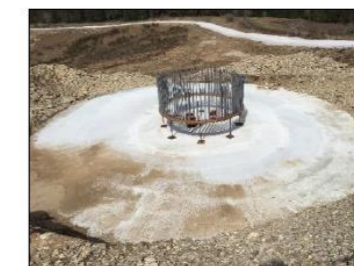
Montage de l'armature Source : Artifex 2018
