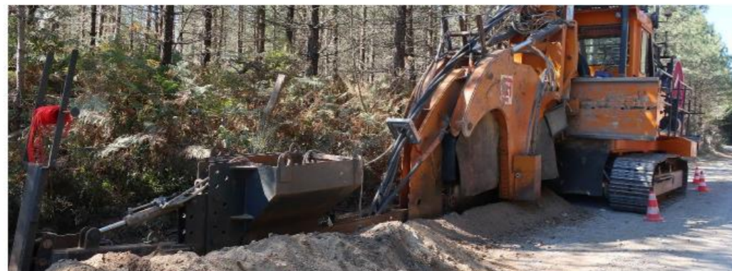
Création d'une tranchée avec une trancheuse Source : Artifex
